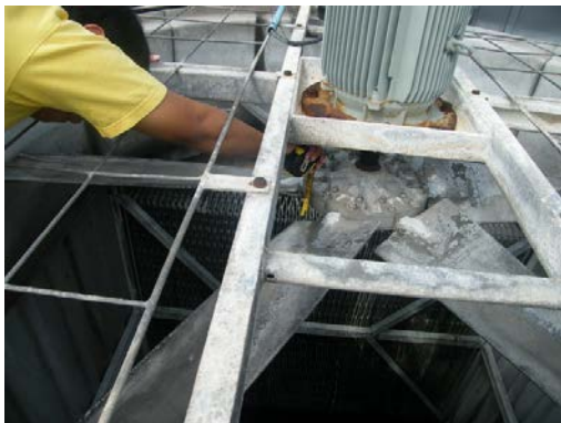
รูปที่ 4 การดำเนินการปรับมุมใบพัด
