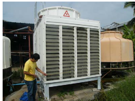
รูปที่ 1 หอผึ่งน้ำเย็น แบบ Induced Draft, Double-Flow Cross Flow
