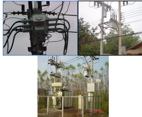
รูปที่ 1 โหลดเบรกสวิตช์ชนิด SF 6 , รีโคสเซอร์ และ AVR
