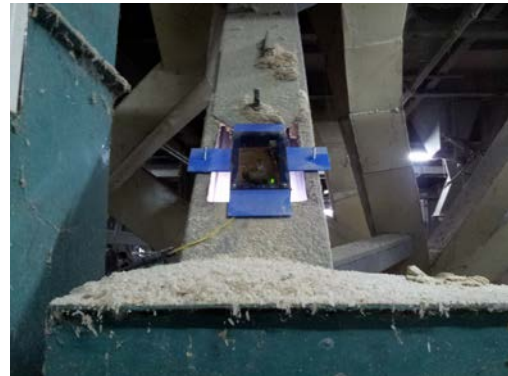
ภาพที่ 8 บริเวณติดตั้งอุปกรณ์
